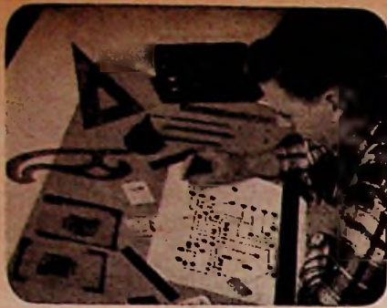
Fig. 6A. Aan de samenstelling van een printed circuit gaan heel wat werkzaamheden vooraf. In de eerste plaats dient de ontwerper aan de hand van het schema een model uit te zetten.
